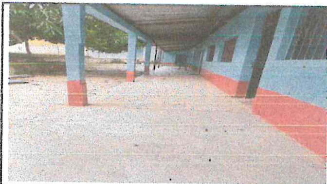
Foto 3: sutitucion de piso de concreto por piso ceramico en corredores .
